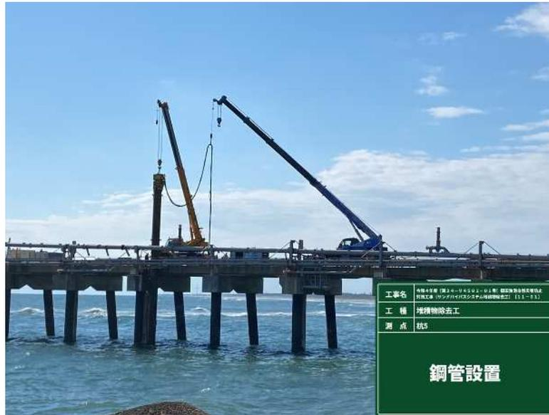
① 棧橋上から、クレーンにより、JP設置予定箇所直下に、鋼管杭(Φ0.9m)を海中に設置
